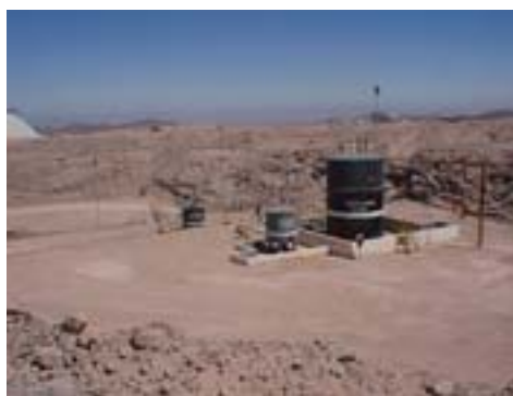
Foto 1. Estanque de almacenamiento de aceite usado, petróleo diesel y mezclador utilizado en Cerro Colorado.
